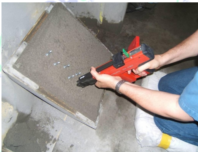
Hình A.4 Dùng súng bắn đinh để đo cường độ sớm của bê tông phun.
